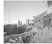
建設中の住居
