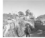
崩壊したままの住居
