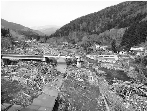
流出した旧南リアス線荒川橋梁 (釜石市2011.3.13)
