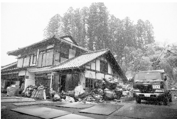
家の解体後も固定資産税は残った (南相馬市小高区 2016.1.29)
