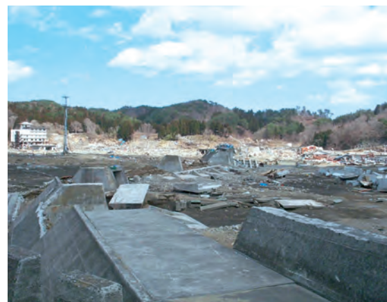
写真⑭破壊された東側の防潮堤
