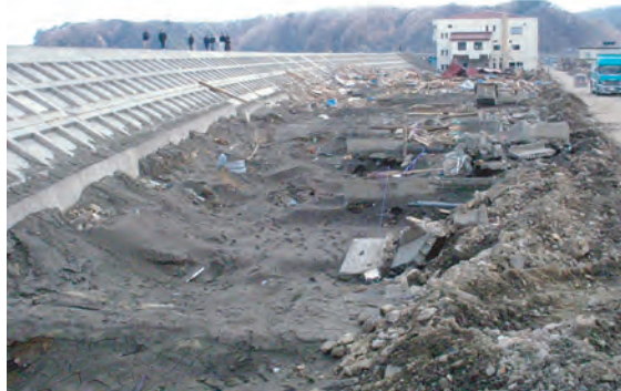
写真⑬防浪堤を越えた津波が地面をえぐった跡
