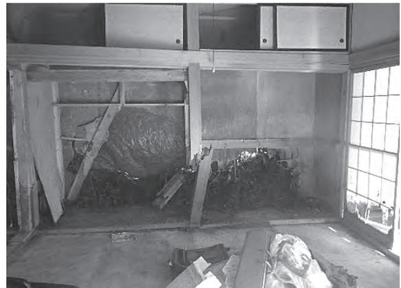
写真3 流入した土砂で折れた柱
