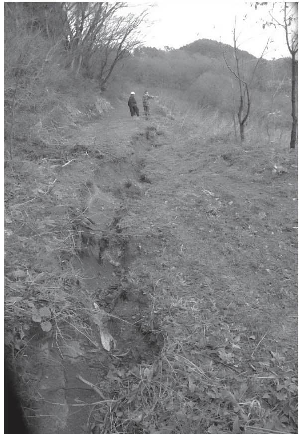
図1のA地点の山側の傾斜変換部にできた亀裂、海岸線にほぼ平行に伸びている。
