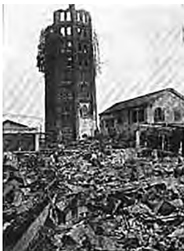
写真8 焼け落ちた12階摩天楼
