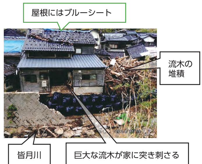
写真8 水害で甚大な被害が生まれた 撮影：田中成行
