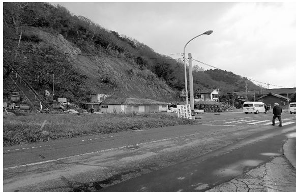
地震の激しさを示す、ひび割れた道路、崩れたままの山肌 2025年12月1日(輪島市名舟町)
